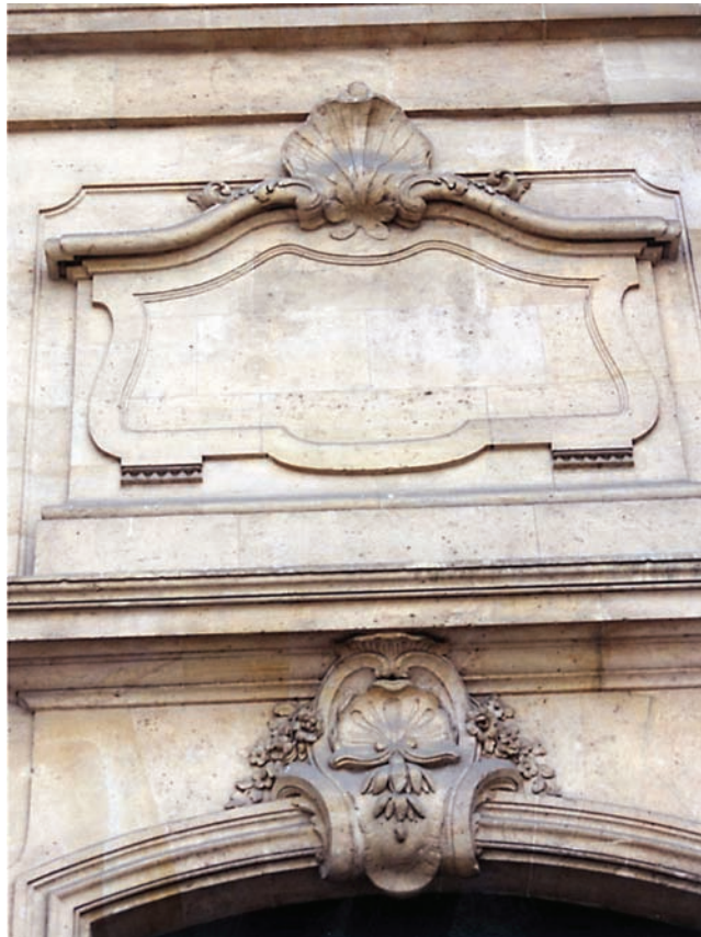
Fig. 26: Nicolas Pineau: Détail d'ornements des entrées latérales de la façade de la cathédrale Saint-Louis de Versailles (1742-1754) (Cl. Ph. Cachau).
